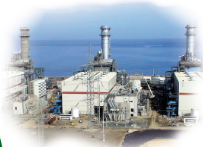
La centrale électrique de Hadjret En Nous en construction
