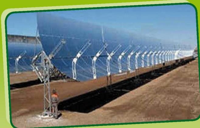
Les centrales à capteurs cylindro-parabolique se composent d'alignements parallèles de longs miroirs hémicylindriques qui tournent autour d'un axe horizontal pour suivre la course du soleil. Les rayons solaires sont concentrés sur un tube absorbeur horizontal, chauffant ainsi le fluide (huile synthétique) qui y circule. Le fluide chauffé génère de la vapeur d'eau qui entraîne une turbine vapeur pour la production d'électricité.
